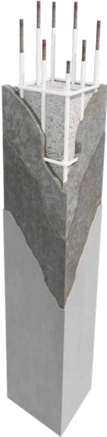
01 RECONSTRUCTION DU BÉTON
