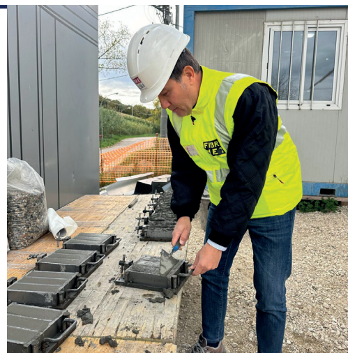
Predisposizione di provini in cantiere a cura del personale specializzato Fibre Net
