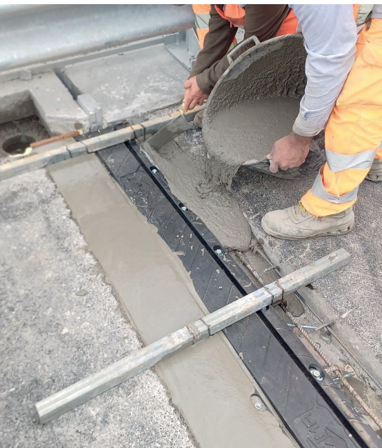
Applicazione di giunti stradali
