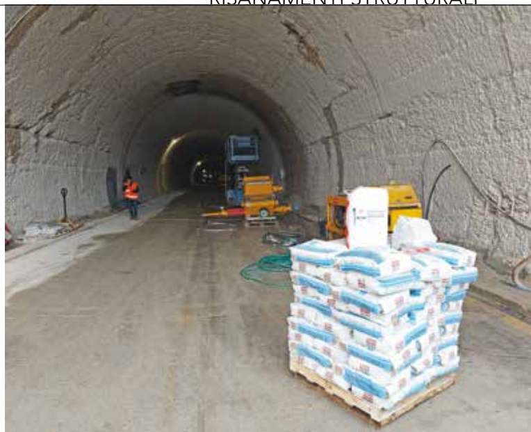
2. Superfici in preparazione e malta struttura Tixo - TX 500
