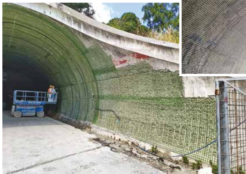
3A e 3B. L'armatura di rinforzo costituita da rete in GFRP
