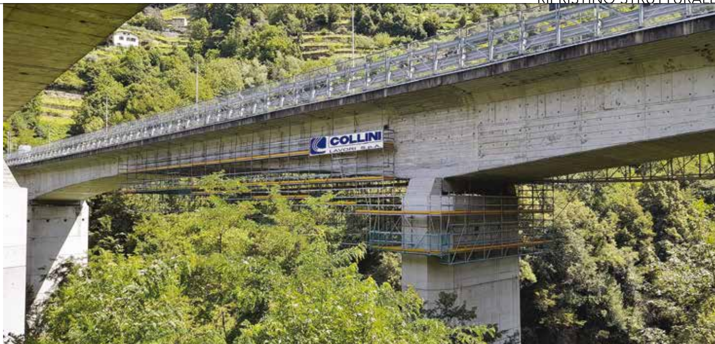
9. Montaggio ponteggio prima dell'intervento di rinforzo
