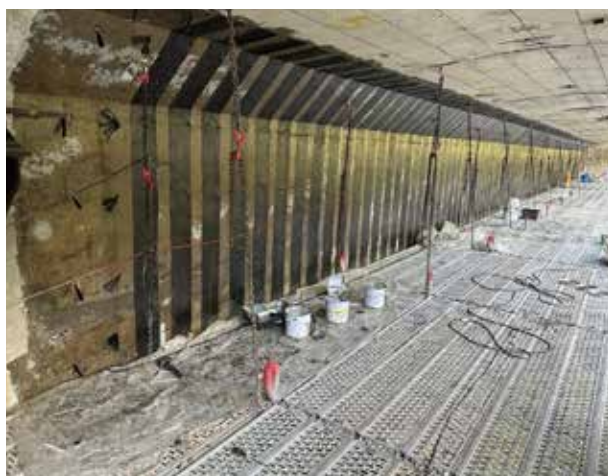
10. Disposizione delle fasce di tessuto in carbonio sui setti
