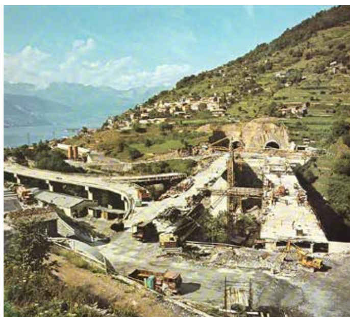
3. Costruzione del viadotto nei primi anni Ottanta
