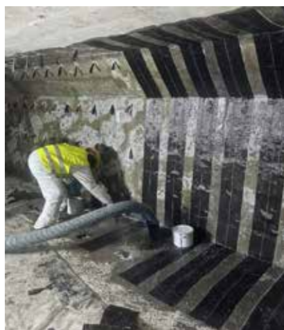
11. Applicazione delle fasce in carbonio
