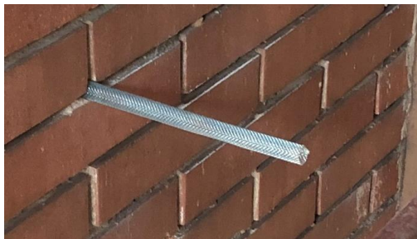
Realizzazione perforo e inserimento bussola
