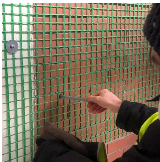
Realizzazione perforo e inserimento bussola e iniezione con resina nel perforo
