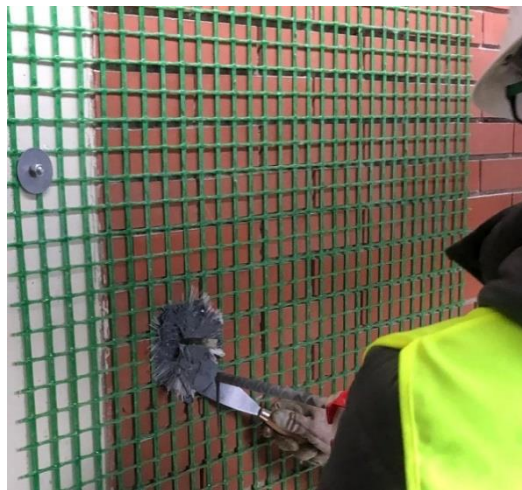
Impregnazione dello sfocco con resina
