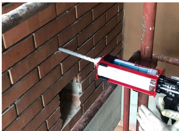
Iniezione con resina nel perforo
