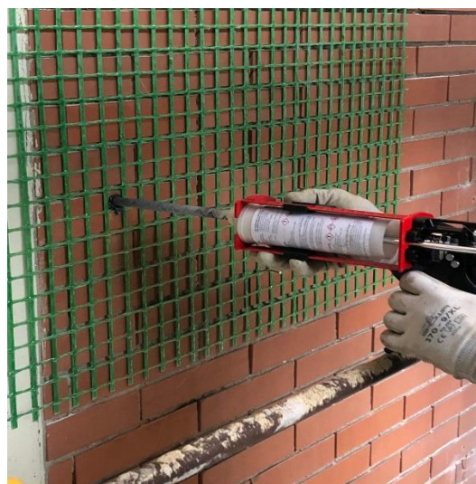
Realizzazione perforo e inserimento bussola e iniezione con resina nel perforo
