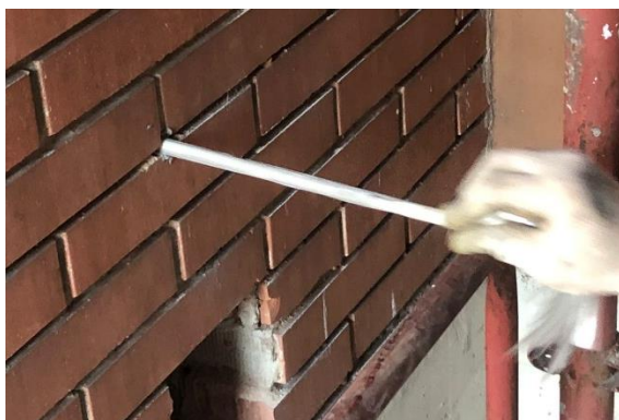
Inserimento del connettore FB-TUP10-VAR1A barra preformata in GFRP con fiocco
