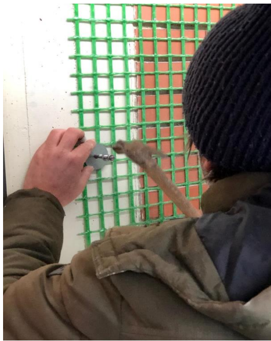
Posa della rete FBMESH_X_T96AR/T192AR e fissaggio con connettori meccanici FBKIT-M8x90INOX/GALV
