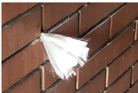
Inserimento del connettore FB-TUP10-VAR1A barra preformata in GFRP con fiocco
