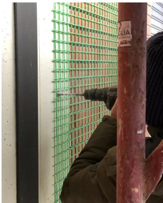
Posa della rete FBMESH_X_T96AR/T192AR e fissaggio con connettori meccanici FBKIT-M8x90INOX/GALV
