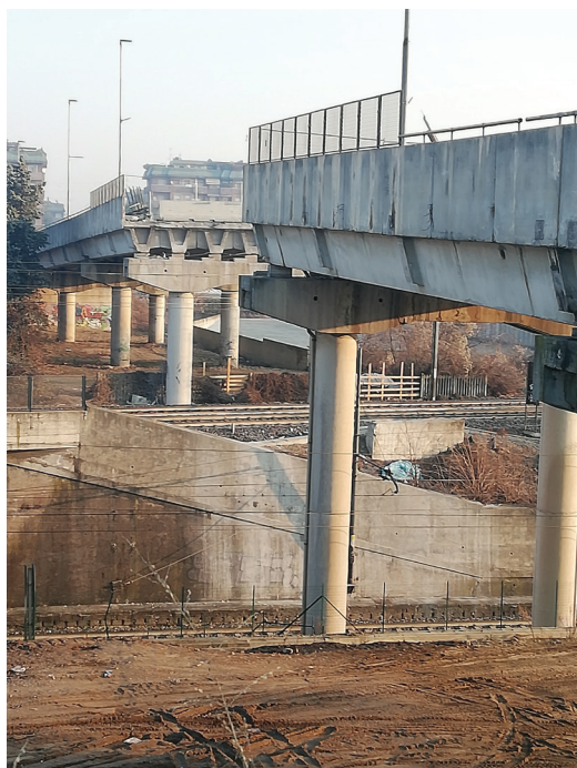
3. Il cavalferrovia con l'impalcato a graticcio con travi a cassoncino in c.a.p. e pile a portale
