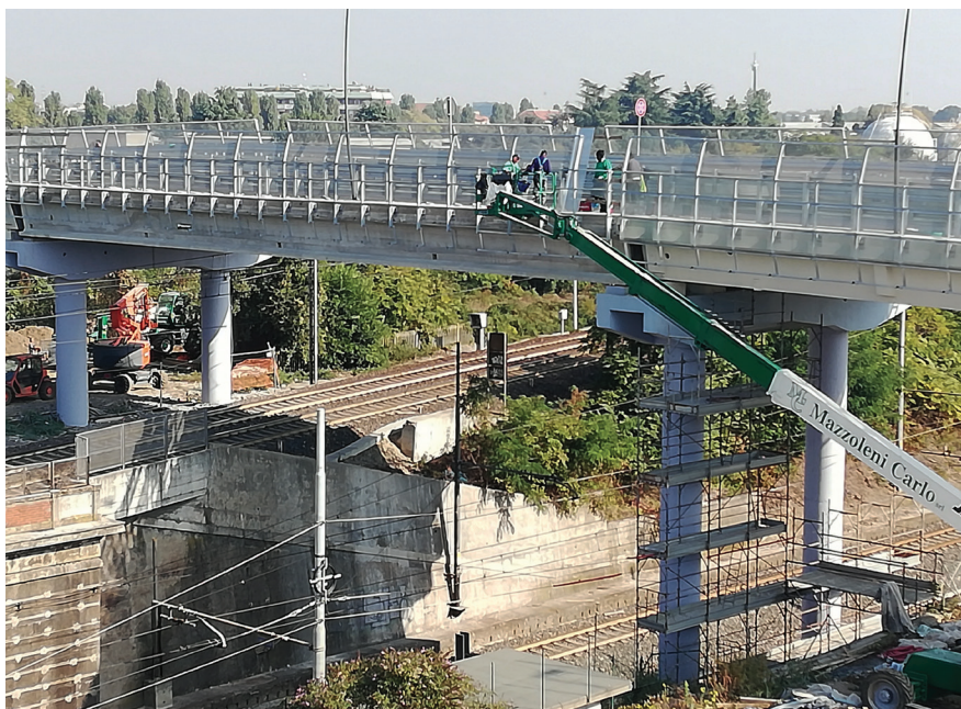
12. Un dettaglio delle fasi lavorative finali
