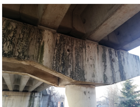
4A, 4B, 4C e 4D. Lo stato di ammaloramento del cavalferrovia ferroviario
