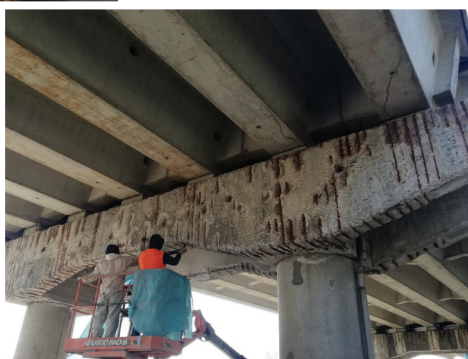
5A e 5B. La lavorazione relative alla preparazione del supporto per il degrado del pulvino
