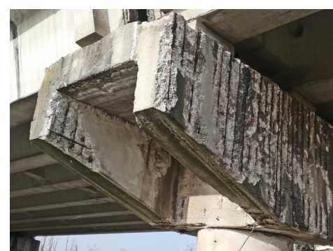
4A, 4B, 4C e 4D. Lo stato di ammaloramento del cavalferrovia ferroviario
