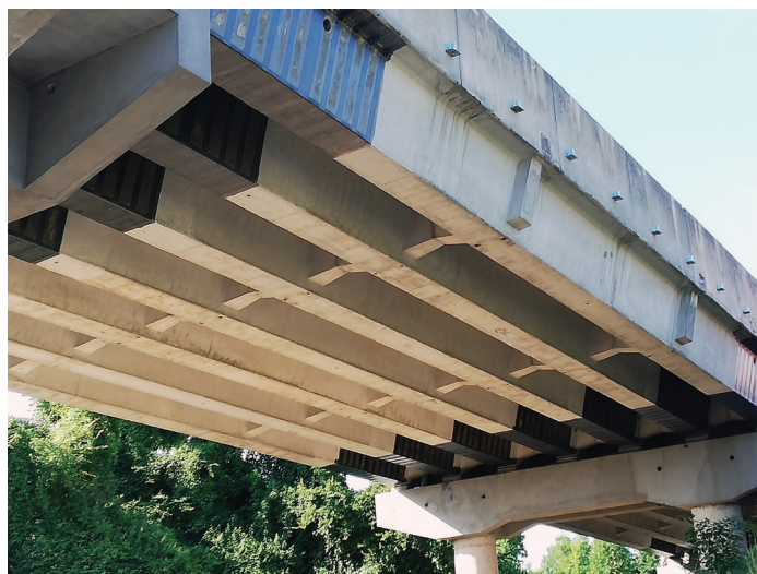
9. Rinforzi in CFRP sulle travi
