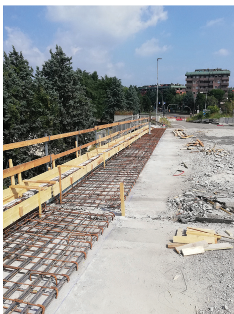
10. L'armatura del cordolo e la soletta laterale
