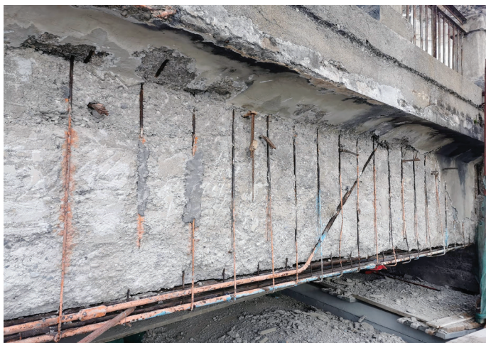
1. Asportazione e pulizia delle parti degradate delle travi e dei traversi
