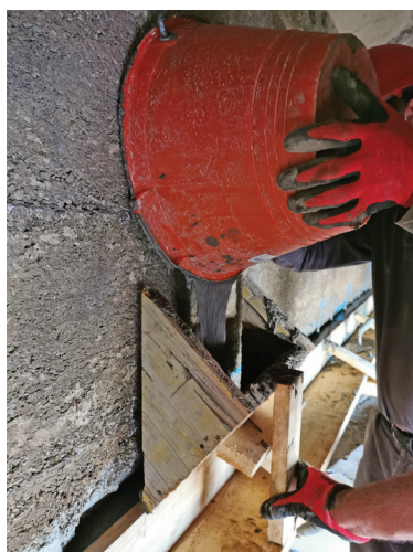
3. Il getto della malta Struttura Fluida - FL 470 per la ricostruzione del bulbo inferiore delle travi di bordo
