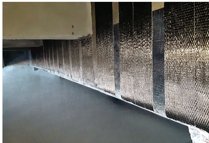
2. L'applicazione in opera del sistema di rinforzo (FRP) Betontex
