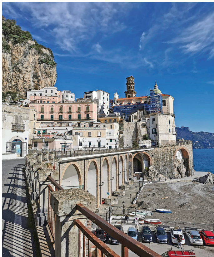
5. Una suggestiva veduta del ponte di Atrani, sulla S.S. 163
