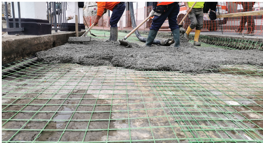
4. Calcestruzzo strutturale alleggerito rinforzato con una rete preformata in vetro (GFRP) Ri-Struttura
