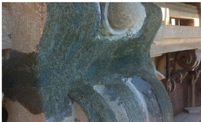
5. Lo spolvero di sabbia consente di realizzare una superficie adeguata alla posa della malta
