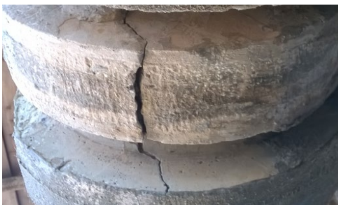
Lo stato di degrado delle mensole in pietra cementizia prima dell'intervento di restauro.
