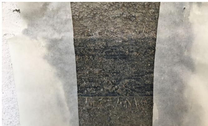
1. Stesura del primer liquido prima dello strato di resina epossidica
