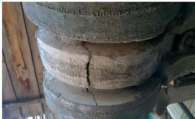
2. La superficie in pietra viene pulita prima della stuccatura delle lesioni e la successiva posa del rinforzo
