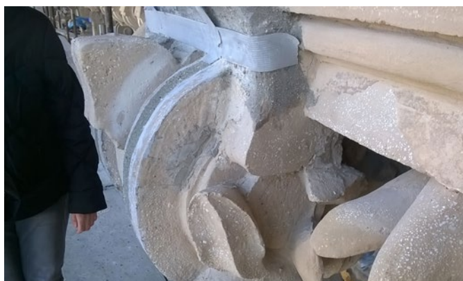
3. Fase intermedia di lavorazione: le superfici sono stuccate e trattate per accogliere il rinforzo
