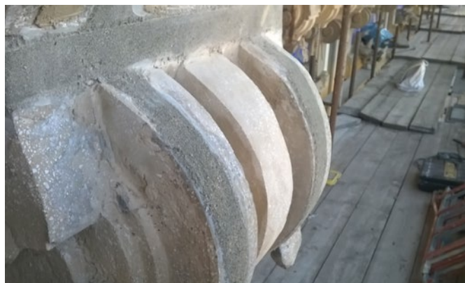
6. La malta a base di calce viene applicata sopra al rinforzo in CFRP
