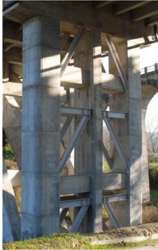
Figura 3 6 Controventatura dei telai in c.a.
