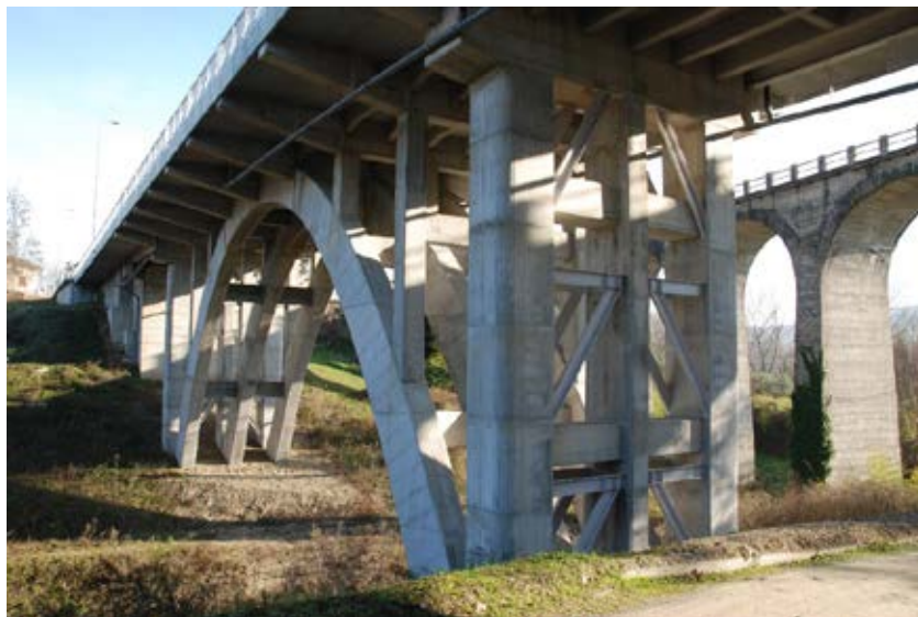
Figura 3-1 Immagine d'insieme del ponte a lavori ultimati
