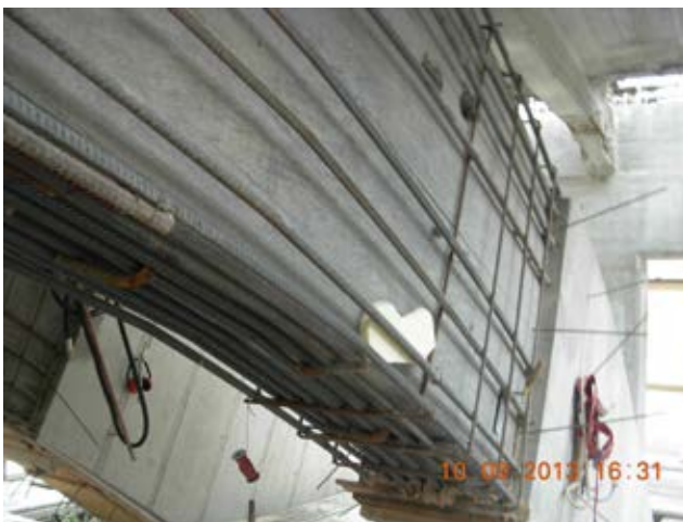
Figura 3 5 Armatura di potenziamento archi in c.a.
