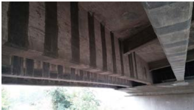
Figura 2-3 Rinforzi a flessione e a taglio in fibra di carbonio
