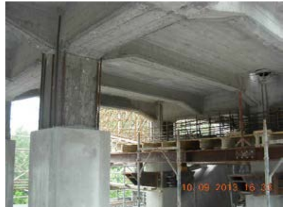
Figura 3 4 Traversi di allargamento impalcato
