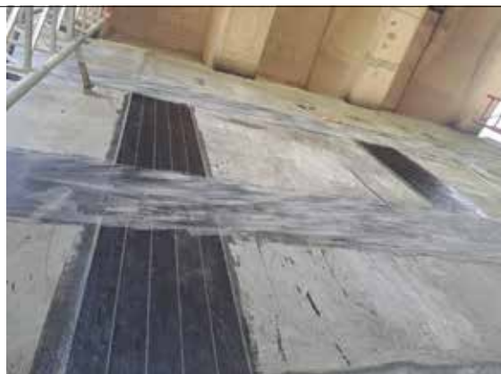
5. Un dettaglio dell'applicazione del rinforzo
