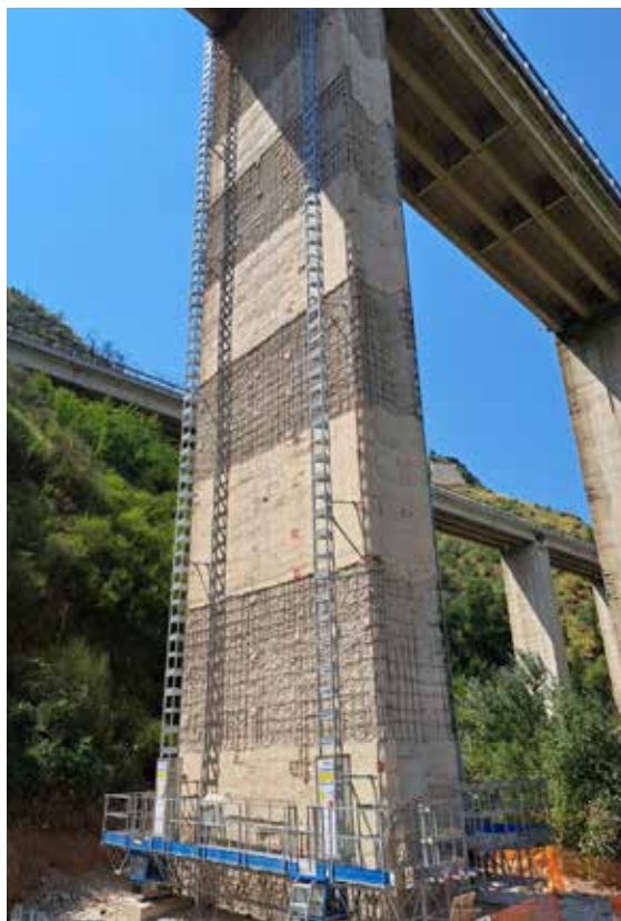
7. Preparazione delle aree di intervento: all'idroscarifica sono seguite la spazzolatura delle armature affioranti e quindi la ricostruzione della geometria originaria con malte ad alta resistenza
