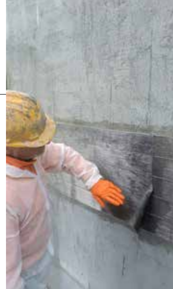
6. L'applicazione del rinforzo FRP in orizzontale
