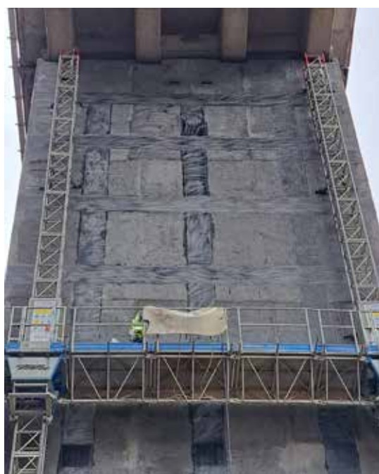
8A e 8B. Il rinforzo strutturale CFRP di Fibre Net applicato su pila
