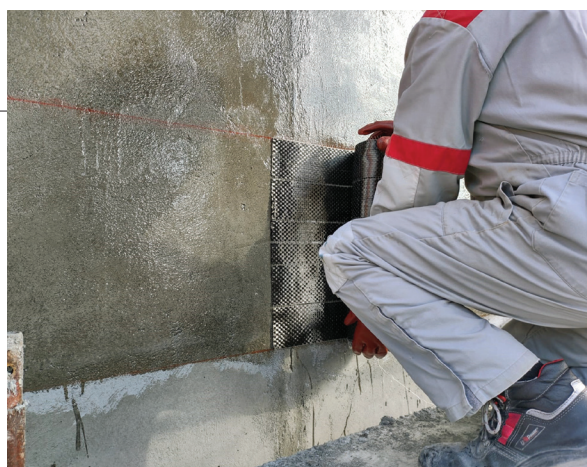
5. La stesura del tessuto in fibre di carbonio
