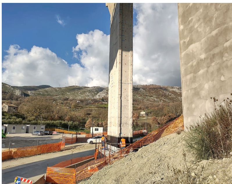
1. Una pila su cui si è intervenuti con la tecnica FRP
