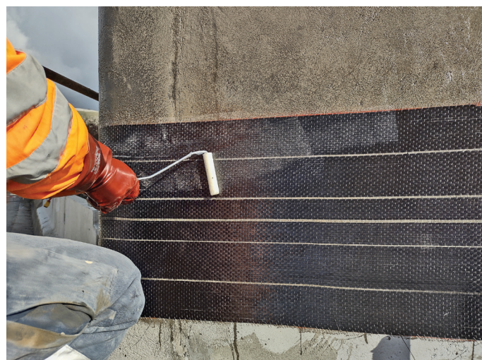
6. Un particolare della tecnica di impregnazione mediante rullo frangibolle
