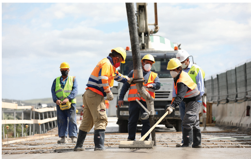
1A e 1B. Il getto sulla soletta del betoncino strutturale fluido
