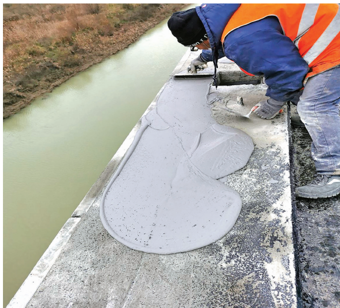
5. L'impermeabilizzazione del cordolo con malta cementizia bicomponente elastica
