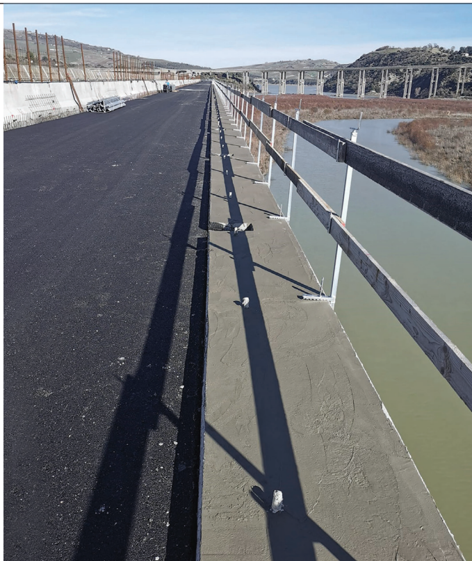
6. Il tappeto in asfalto e il cordolo in calcestruzzo
